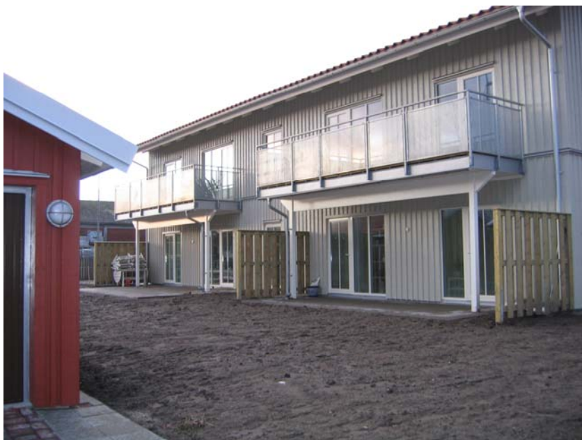
Bildtext: En av huskropparna i Frillesås byggda i två våningar. Foto: Ulla Jansson, LTH
