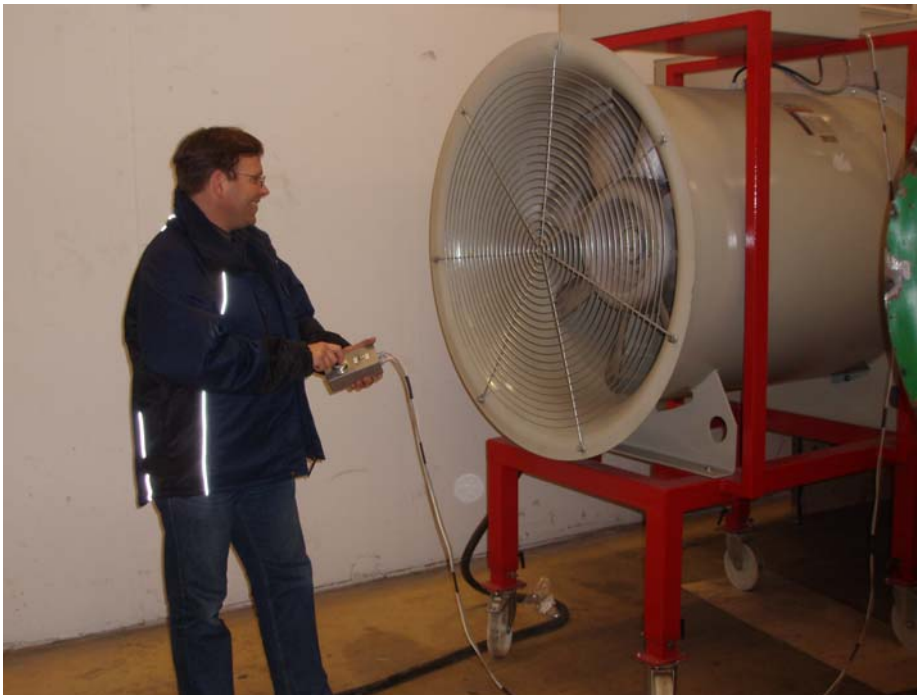
Figur 4.3 Täthetsprovning med en stor fläkt vars kapacitet klarar stora byggnader såsom industrihallar, kontorsbyggnader mm.
